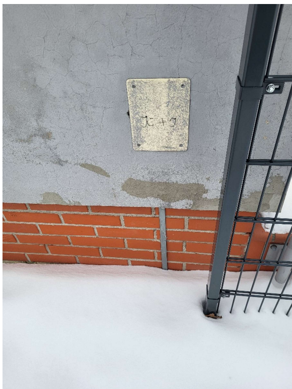
BUDYNEK PRZEDSZKOLA DETAL OGRODZENIA PRZY ELEWACJI (DO PRZEŁOŻENIA) INSTALACJA UZIEMIAJĄCA (DO WYMIANY)
