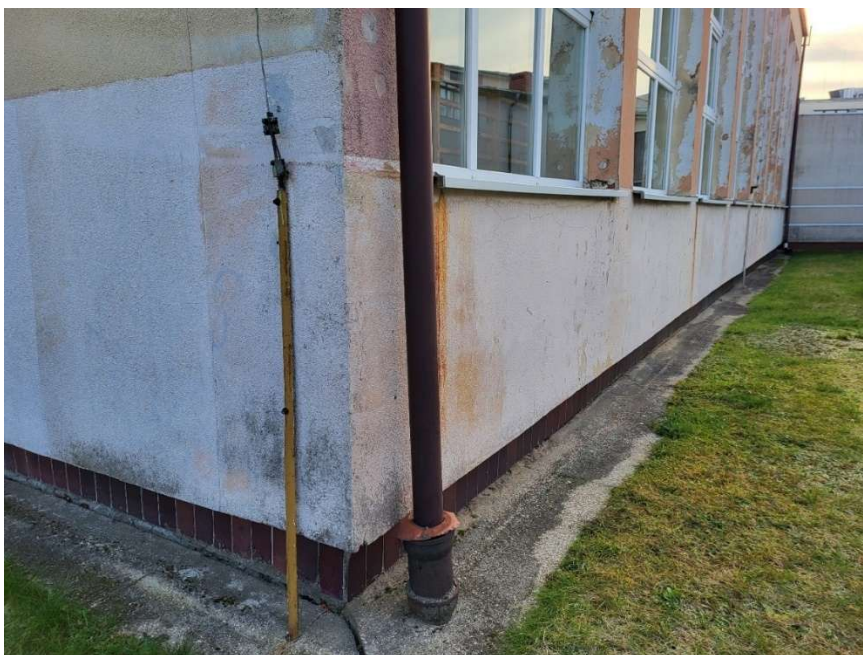
SALA GIMNASTYCZNA DETAL: INSTALACJA UZIEMIAJĄCA, RURA SPUSTOWA PODŁĄCZONA DO INSTALACJI ODWADNIAJĄCEJ PODZIEMNEJ (INSTALACJA PODZIEMNA DO WYMIANY I PRZEŁOŻENIA, TJ. DOSTOSOWANIA DO NOWEJ GRUBOŚCI ELEWACJI)
