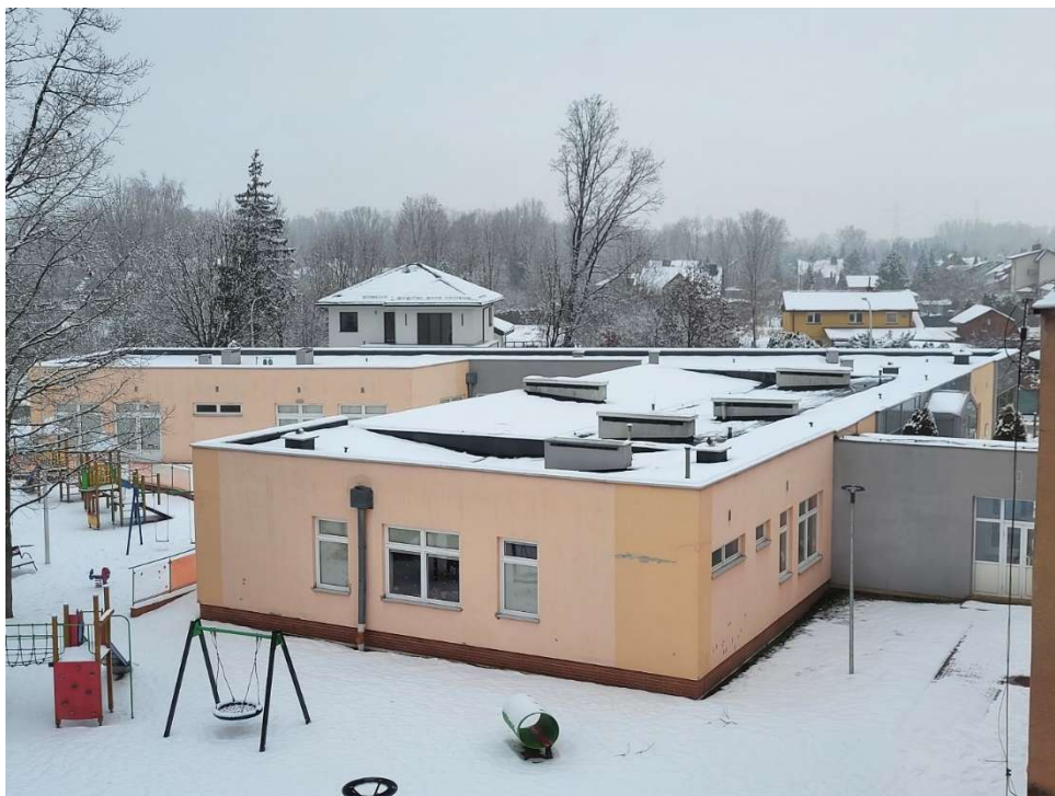
PRZEDSZKOLE WIDOK OD STRONY ZACHODU, NA ZDJĘCIACH PRZEDSZKOLA WIDOCZNE RURY SPUSTOWE PODŁĄCZONE DO INSTALACJI ODWADNIAJĄCEJ PODZIEMNEJ (DO WYMIANY I PRZEŁOŻENIA - DOSTOSOWANIA DO NOWEJ GRUBOŚCI ELEWACJI)
