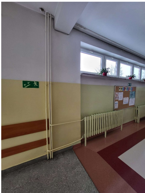
KORYTARZ SZKOŁY, INSTALACJA GRZEWcza, GRZEJNIKI I OSŁONY GRZEJNIKÓW DO WYMIANY NA NOWE
