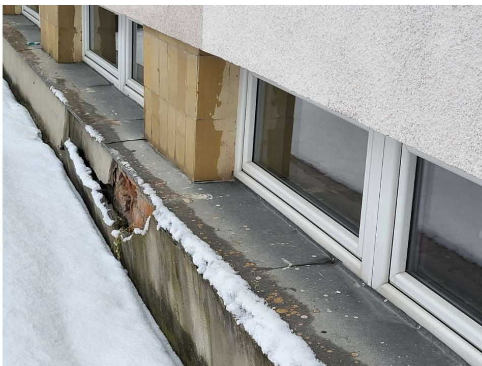
BUDYNEK A ZNISZCZONY TYNK COKOŁU
