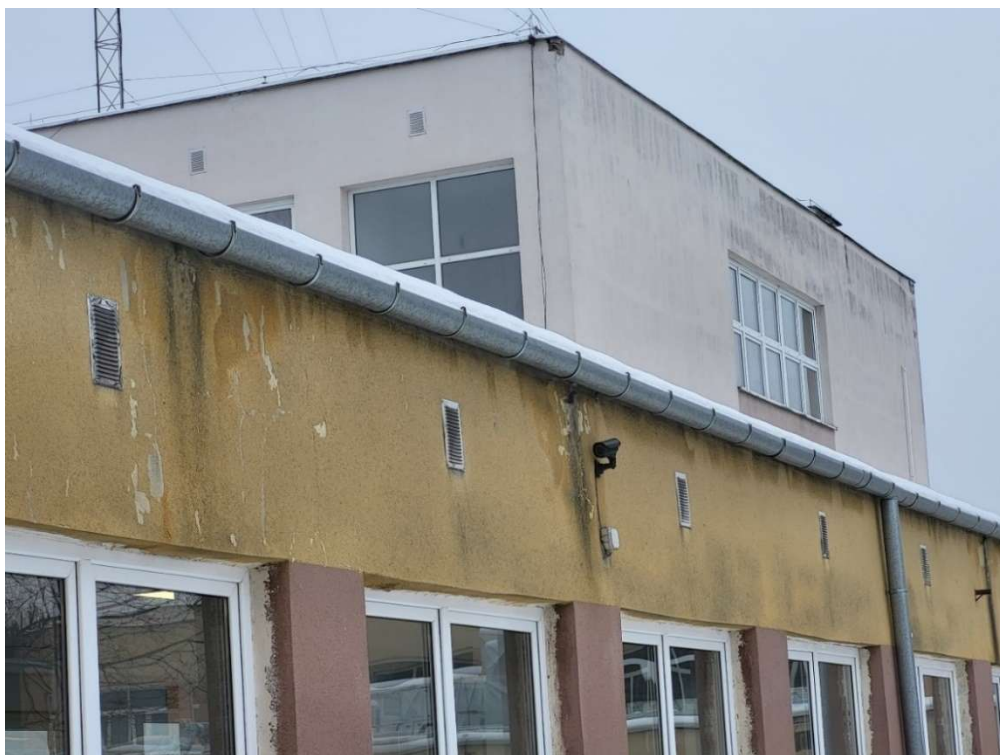
ŁĄCZNIK Ł1 (DETAL) ORAZ BUDYNEK B (NA DRUGIM PLANIE), WSZYSTKIE KRATKI WENTYLACYJNE DACHU DO WYMIANY
