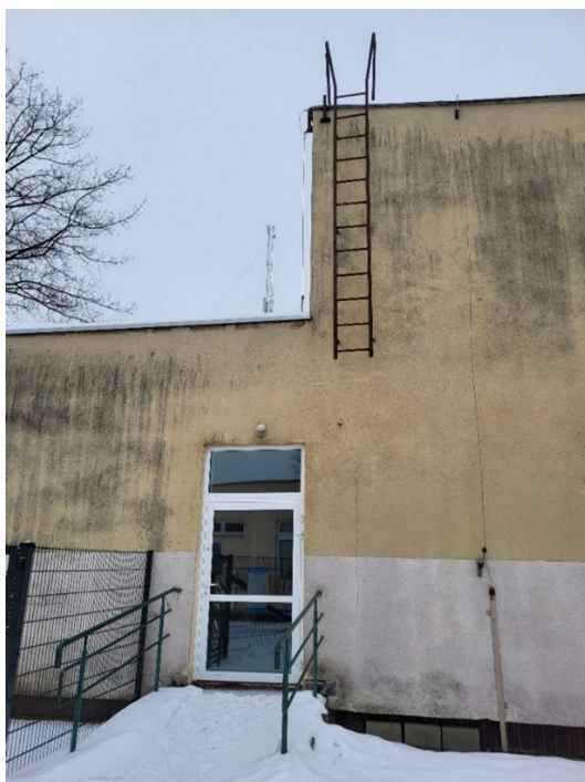
SALA GIMNASTYCZNA WIDOK OD POŁUDNIOWEGO – WSCHODU, DRZWI WEJŚCIOWE SĄ NOWE, POZA ZAKRESEM TERMOMODERNIZACJI, POZOSTAŁE ELEMENTY (DRABINKA , OBRÓBKI, INSTALACJA UZIEMIAJĄCA – DO WYMIANY), BALUSTRADY STYKAJĄCE SIĘ Z ELEWACJĄ – DO PRZEŁOŻENIA
