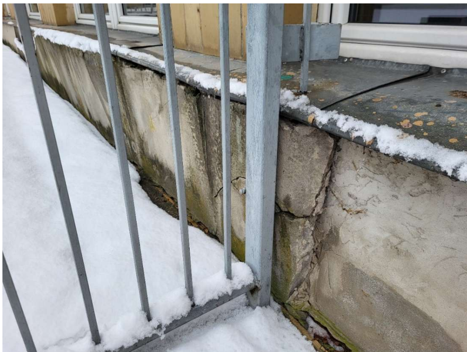
BUDYNEK A: (ELEWACJA PÓŁNOCNO – WSCHODNIA) – ZNISZCZONY TYNK COKOŁU ORAZ BALUSTRADA STYCZNA DO ELEWACJI - DO PRZEŁOŻENIA
